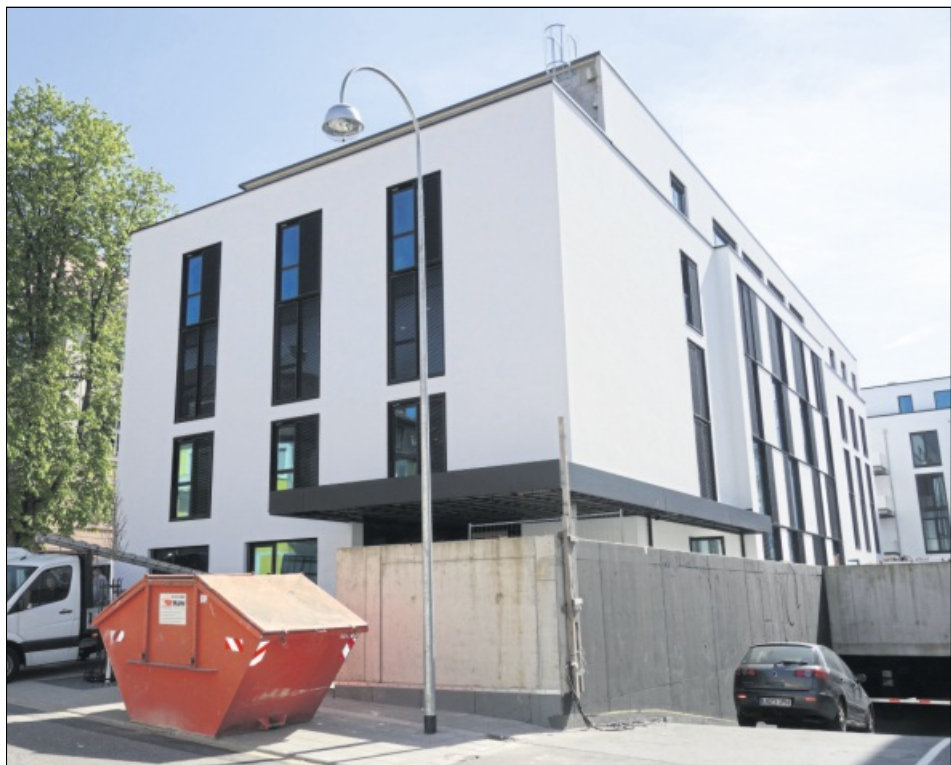
DIE LETZTEN ARBEITEN LAUFEN: Obwohl der Neubau des Medical Centers beim Roomers noch nicht ganz fertig ist, sind bereits zwei Arztpraxen eingezogen. Foto: Rudolphi
